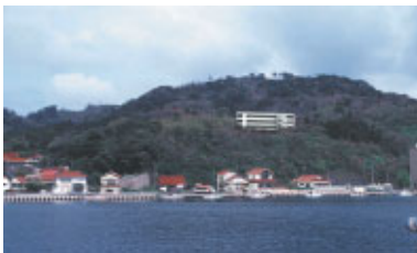
中腹にモンタージュで表した陸屋根ビルについて外壁を明るくしすぎると(明度 9.0 相当)建物が浮かび上がる。
