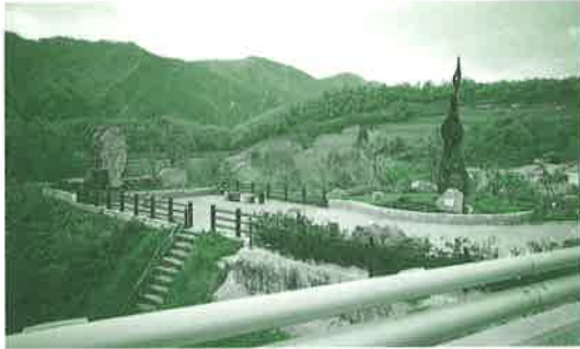
奥出雲オロチループ（横田町） 橋詰めのポケットパーク
