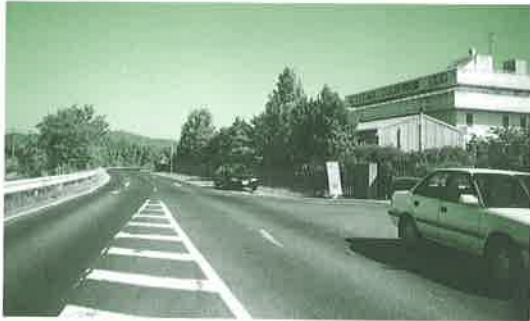
東部浄化センター（松江市）
