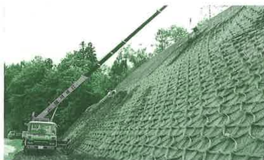
生活環境保全林整備事業 施工中の法面（平田市）
