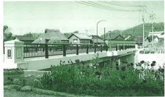
穂多留橋（横田町） 花木による橋詰めの緑化
