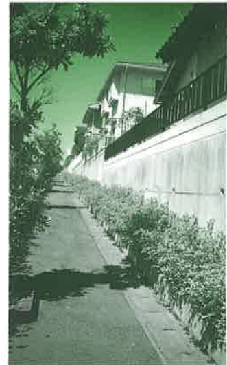
朝日ヶ丘住宅（松江市） 擁壁前面の低木植栽
