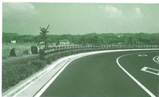
出雲空港線（斐川町） 防護柵足元の低木植栽
