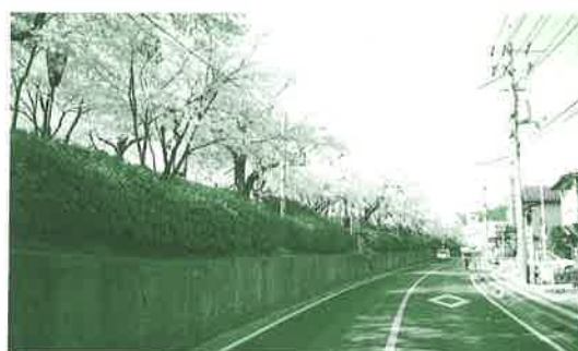
斐伊川（木次町） えん堤裏の桜とツツジによる緑化
