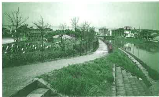
北田川（松江市） 隣接小学校との一体整備
