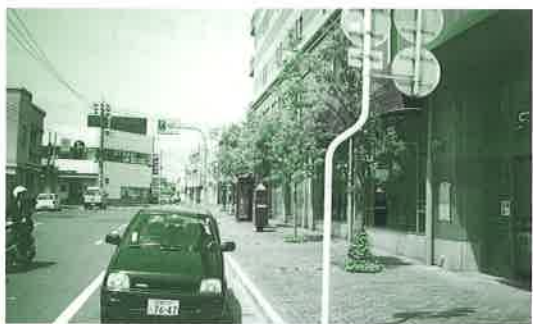
スティックビル (松江市) 壁面のセットバックによる歩道への緑化スペースの確保
