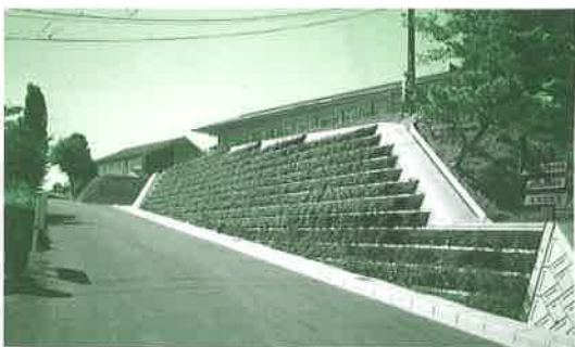
生馬小学校（松江市） 緑化ブロックによる擁壁の修景
