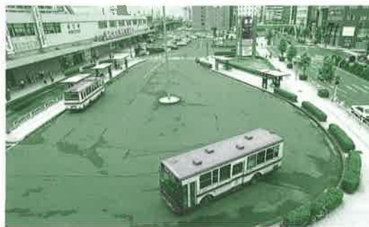
高木植栽の不足した駅前広場（松江市）
