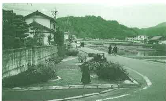
益田川（益田市） えん堤を拡幅して緑化した例
