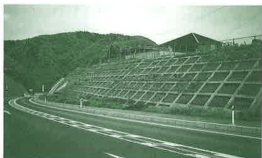
奥出雲オロチループ（横田町） 苗木植栽によってコンクリート法枠を ぼかしている
