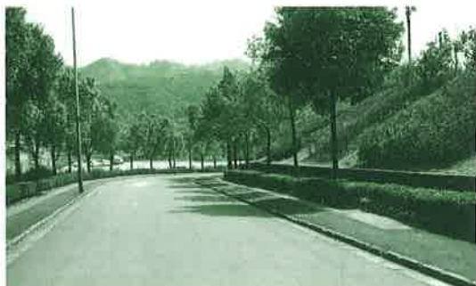
広瀬町総合公園進入路（広瀬町） ブロック積み擁壁前面を低木と高木で修景
