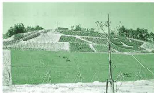
施工後の法面 急斜面に潤いのある緑ができた
