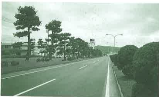
国道9号 (松江市) 中央分離帯の緑化
