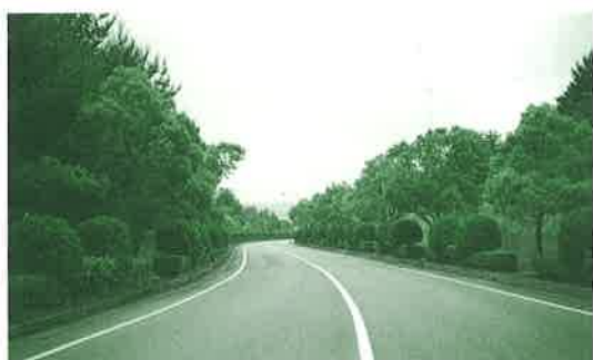
石見海浜公園進入路（浜田市） 両脇の法面と一体的に緑化
