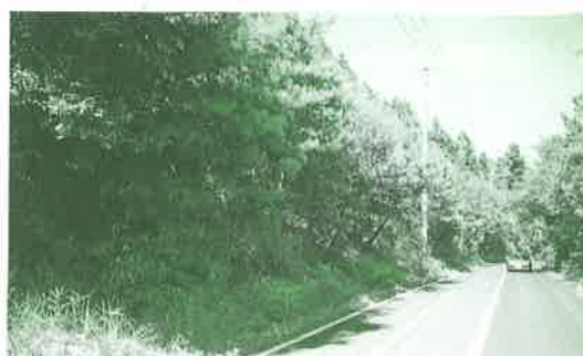
湖北広域農道（松江市） 林地へ復元した法面
