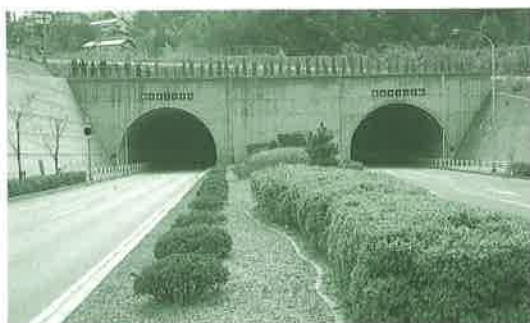
桧山トンネル（松江市） 坑口付近の道路緑化
