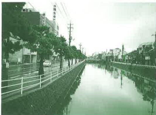
京橋川（松江市）
