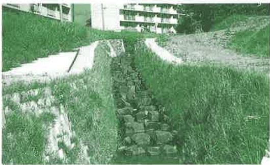
多伎塚川（多伎町） 自然石を用いた斜路、緑化ブロック等を採用した多自然型川づくり
