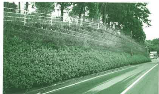
楽山公園（松江市） 緑化ウォールによる外周部の緑化
