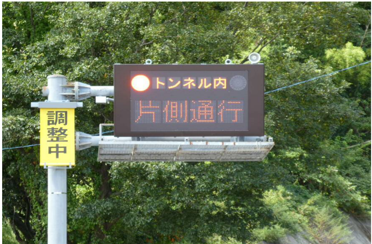
ロービームLED使用前のトンネル坑口表示機(参考)
