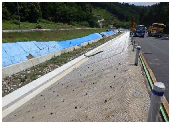
ラス張工 (盛土面)
