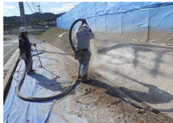
【防草土吹付作業】
