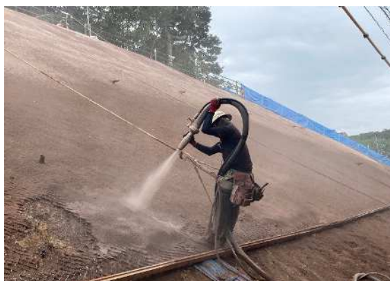
【乾式による吹付作業】
