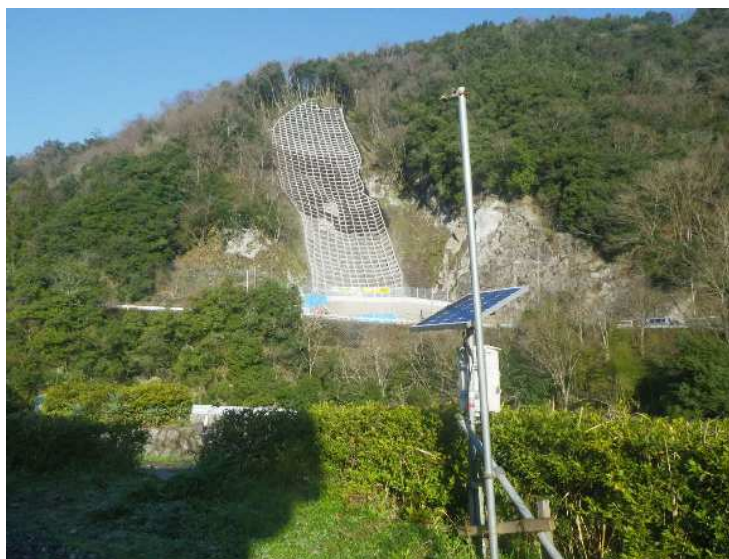
カメトル設置写真
