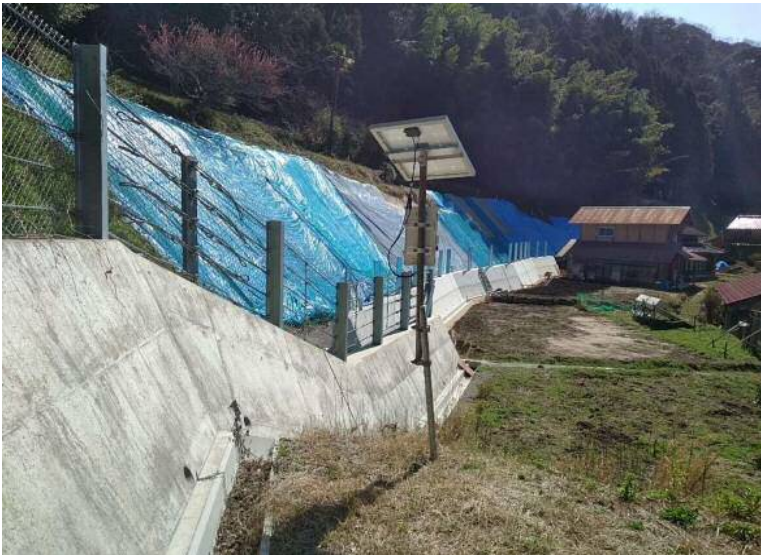
カメトル設置写真 背面
