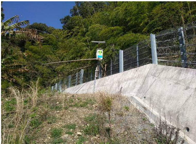
カメトル設置写真 正面
