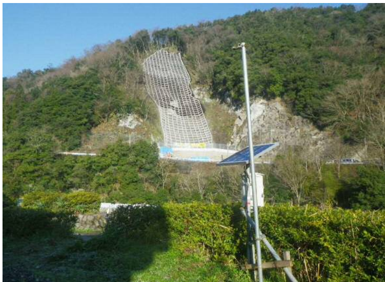
カメトル設置写真
