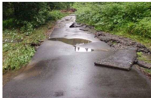
写真：舗装の被災
