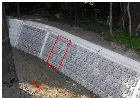
被災前写真（ブロック段数 4.5 段）
