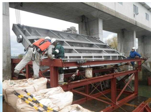
補修工事(扉体の取替え)
