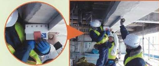
**1 PCT桁における着磁状況 (磁石ユニットを用いて)**
