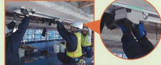
**2 PCT桁における磁束密度測定状況 (磁気計測ユニットを用いて)**
