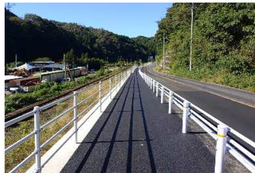
張出歩道完成写真 ↑ 三成方面
