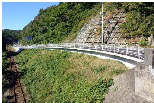
張出歩道完成写真(側面)
