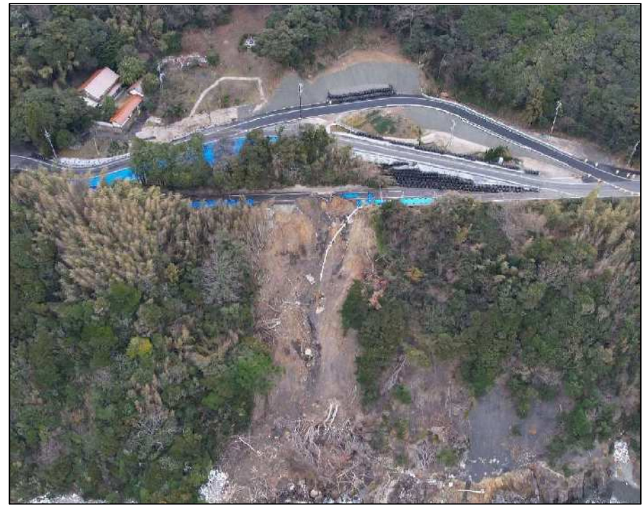
【仮設迂回道路の整備状況】
