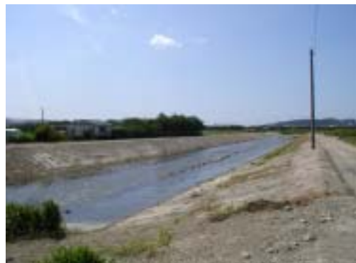
実施後排水路護岸状況
