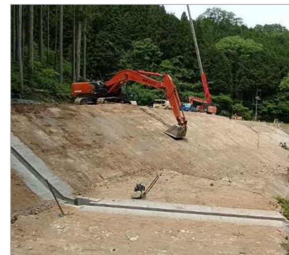
▲3DMG油圧ショベルを活用 した法面整形
