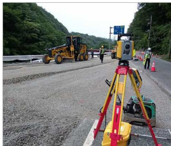
▲3DMGモータグレーダによる 路盤敷均し作業
