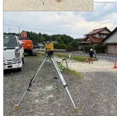
▲自動追尾型トータルステーション による現地測量
