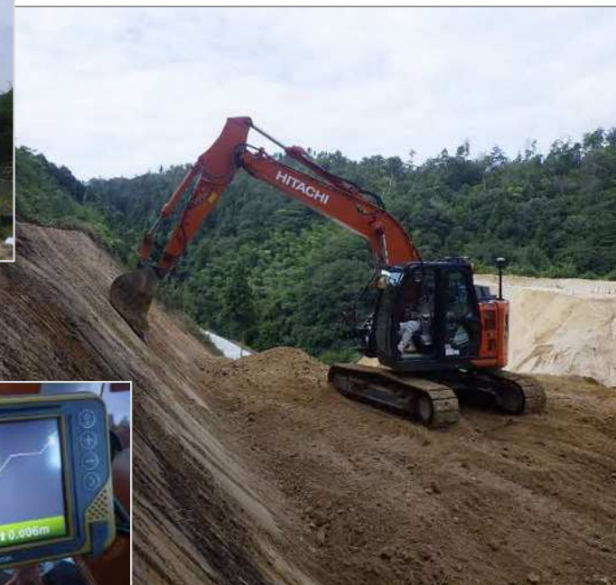
3DMG油圧ショベルを ▼活用した掘削作業
