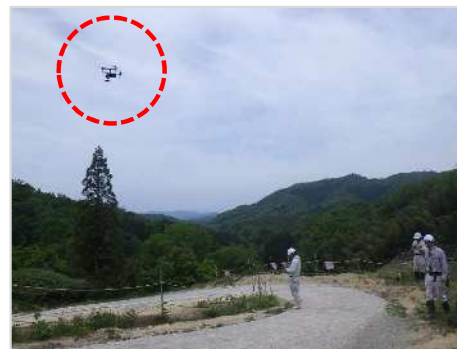
▲UAVを活用した 起工測量
