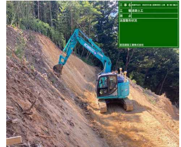
▲3DMG油圧ショベルを活用した 掘削（法面整形）作業
