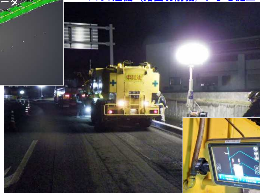
▼ICT建機（路面切削機）による施工
