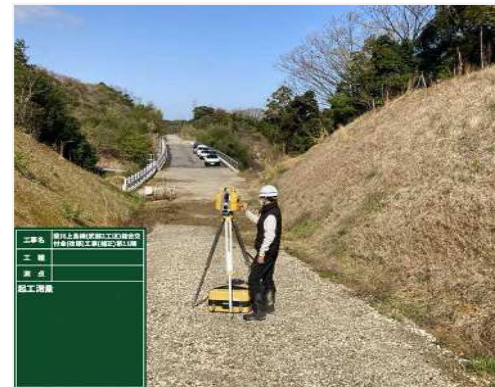
▲ 地上型レーザースカナーを活用した起工測量
