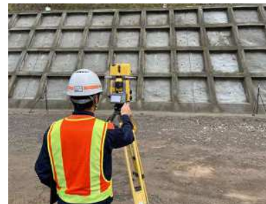
▲地上型レーザー Scanner を活用した起工測量
