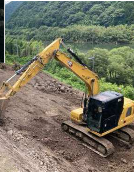
▲3DMCバックホウを活用した掘削作業
