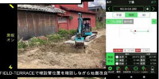
▲ 地下埋設物把握データを活用した簡易型マシンガイダンス
