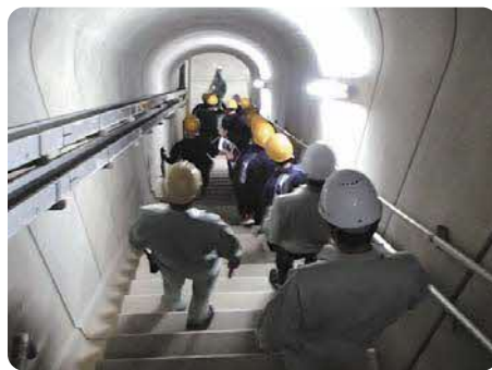
監査廊、普段入れない空間を体感!
