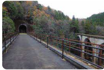
第一下府川橋梁(新線)と4連アーチ橋(旧線)
