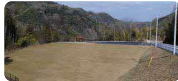
グラウンドゴルフもできる多目的広場(第二浜田ダム)
