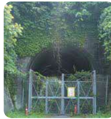
上府第一トンネル
