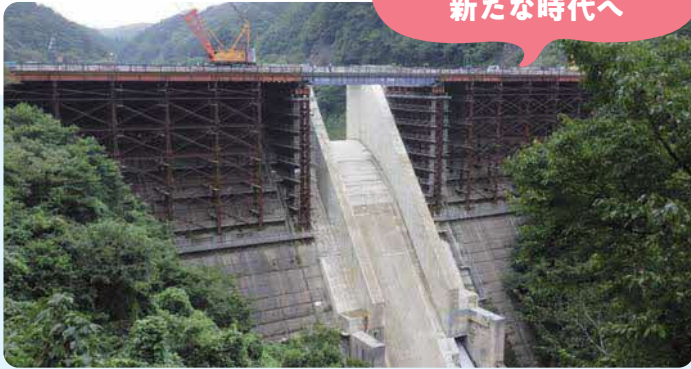
令和元年施行中
