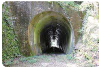
有福第二トンネル
