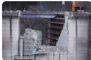
浜田ダム既設堤体取り壊しの様子
