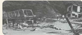
被災した桜江大橋(出典:昭和47年7月豪雨災害誌)
