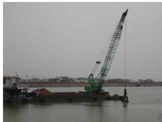
覆砂工事の様子
