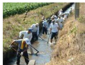
農業用排水路の泥上げ
