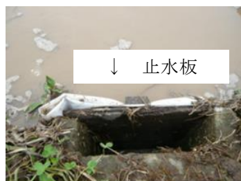
止水板の設置
