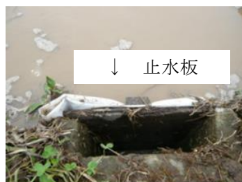
止水板の設置
