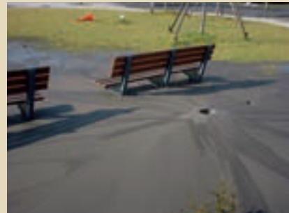
工業団地の液状化現象による噴砂 （境港市）
