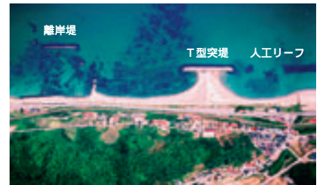
海岸侵食を防ぐ海岸保全施設（持石海岸）
