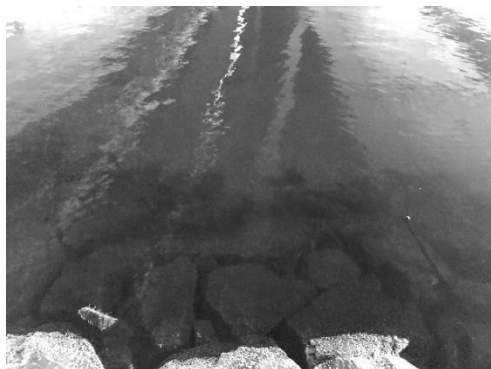
写真1 橋の下の様子(図1の②の地点)
