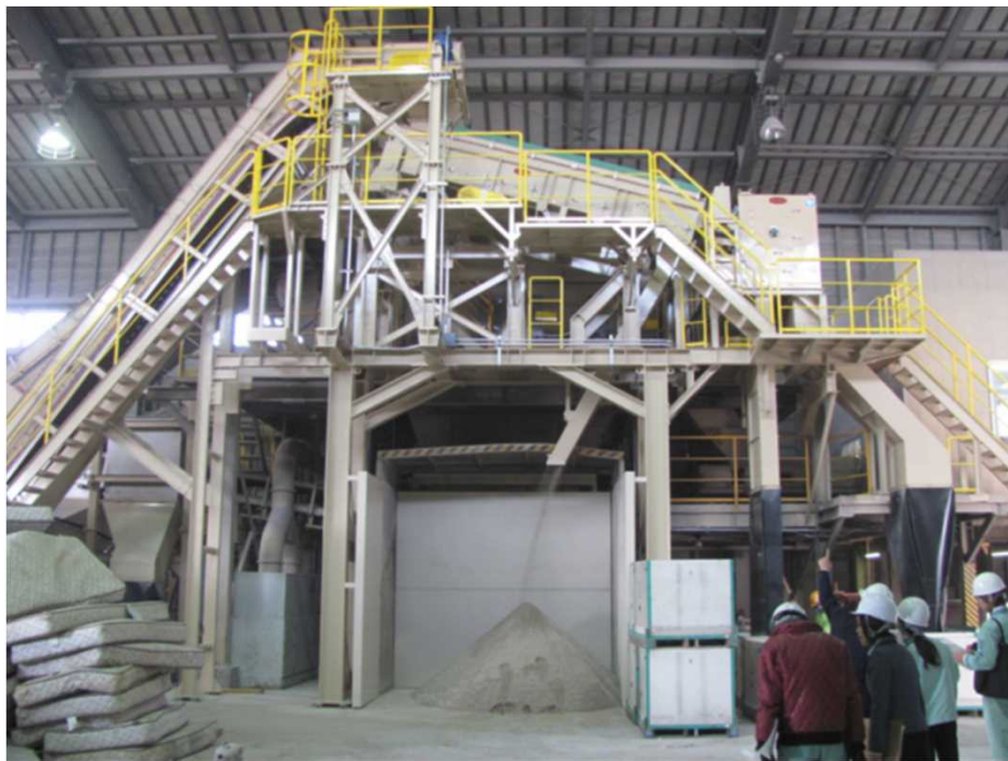
混合廃棄物精選設備
