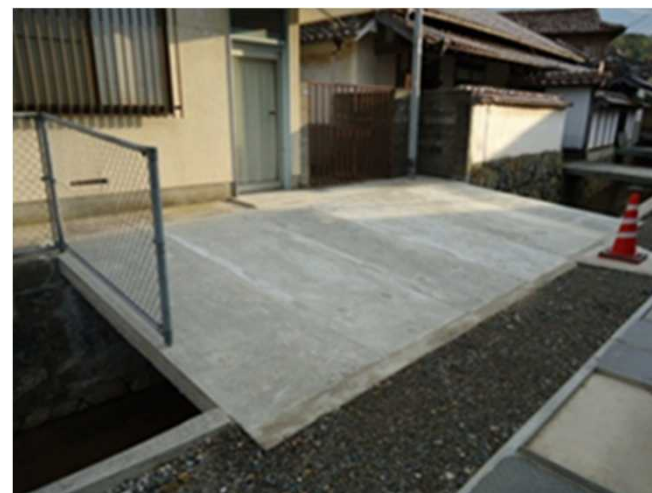
規格外瓦粉碎物を配合した鉄筋コンクリート床板
