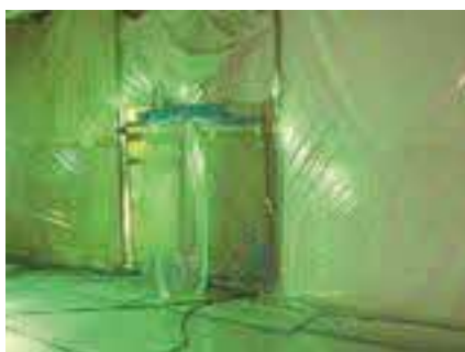
壁面の負圧隔離養生例
