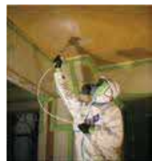
粉じん飛散抑制剤の散布による湿潤化
