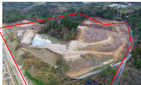
造成工事着工前
