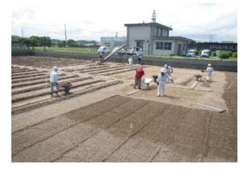
緩速ろ過池砂削り作業
