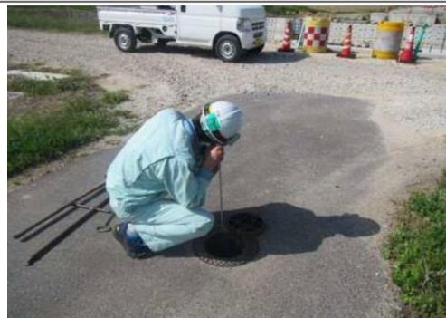
送水管路漏水状況確認作業
