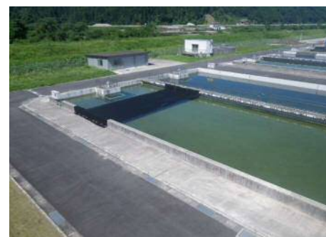
ろ過池遮光シート設置(斐伊川)
