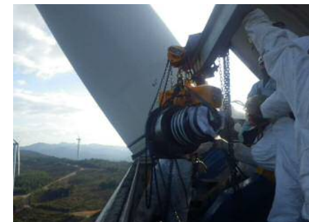
江津高野山風力発電所高速軸ベアリング取替工事
