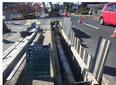
揖屋地区送水管路布設替工事
