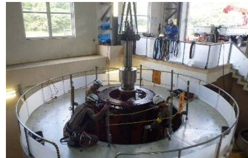
三隅川発電所リニューアル工事(発電機撤去作業中)
