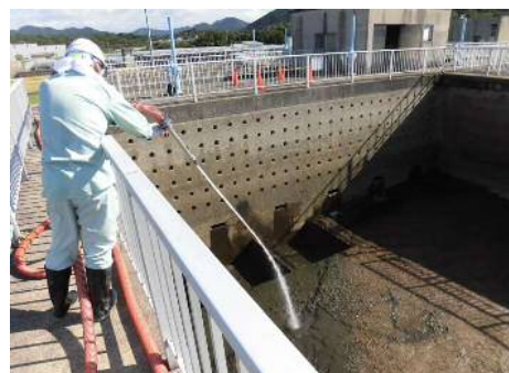
沈殿池清掃(江の川)
