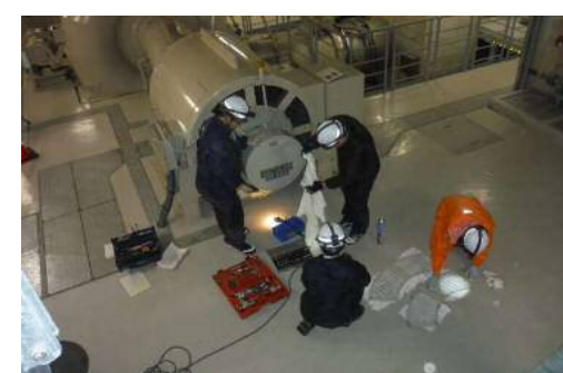
停電作業(志津見発電所:技術力継承)
