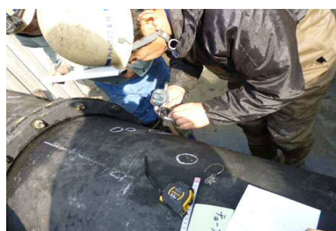
送水管健全度診断
