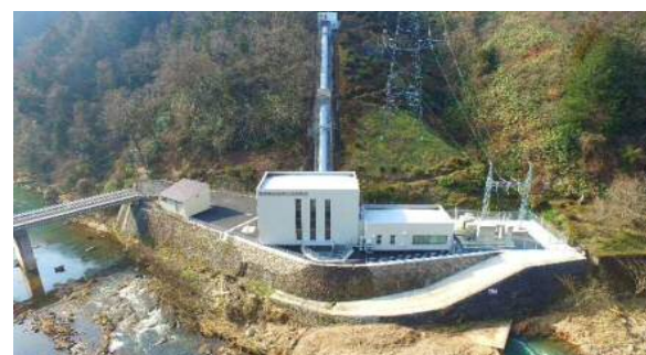
三成発電所リニューアル工事(完成)
