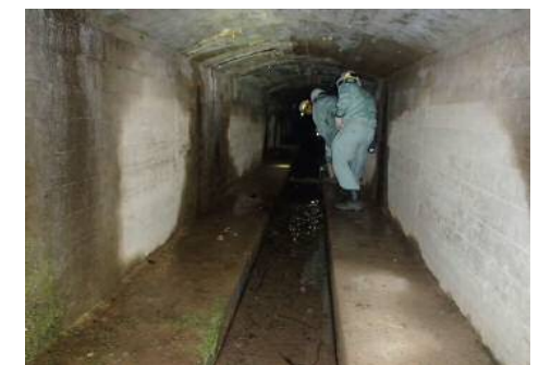
三隅川発電所隧道点検(ダム水路主任技術者資格要)
