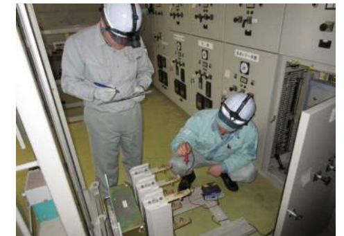
停電作業(今津浄水場)
