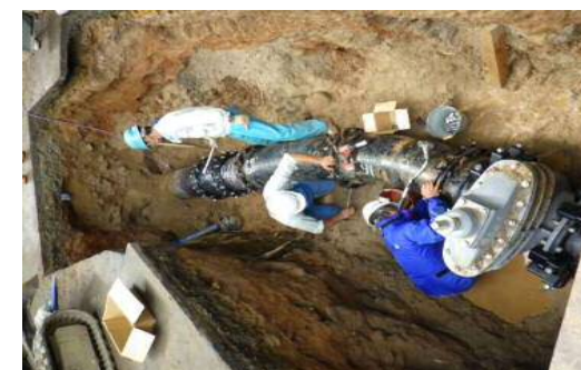
漏水修繕工事(斐伊川水道管路松江市布志名配水池付近)
