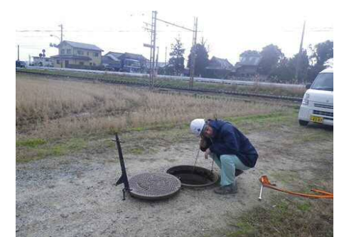
音聴棒による漏水確認作業
