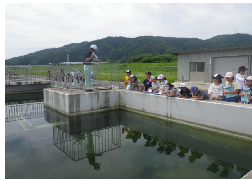
施設見学(三代浄水場)
