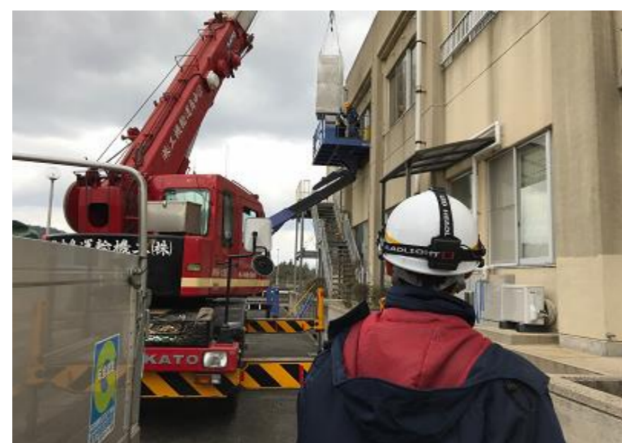
電気設備更新工事(江津浄水場)
