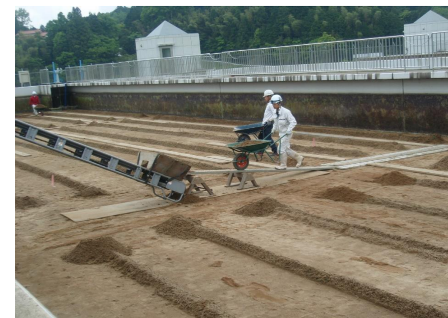
緩速ろ過池砂削り取り工事(三代浄水場)
