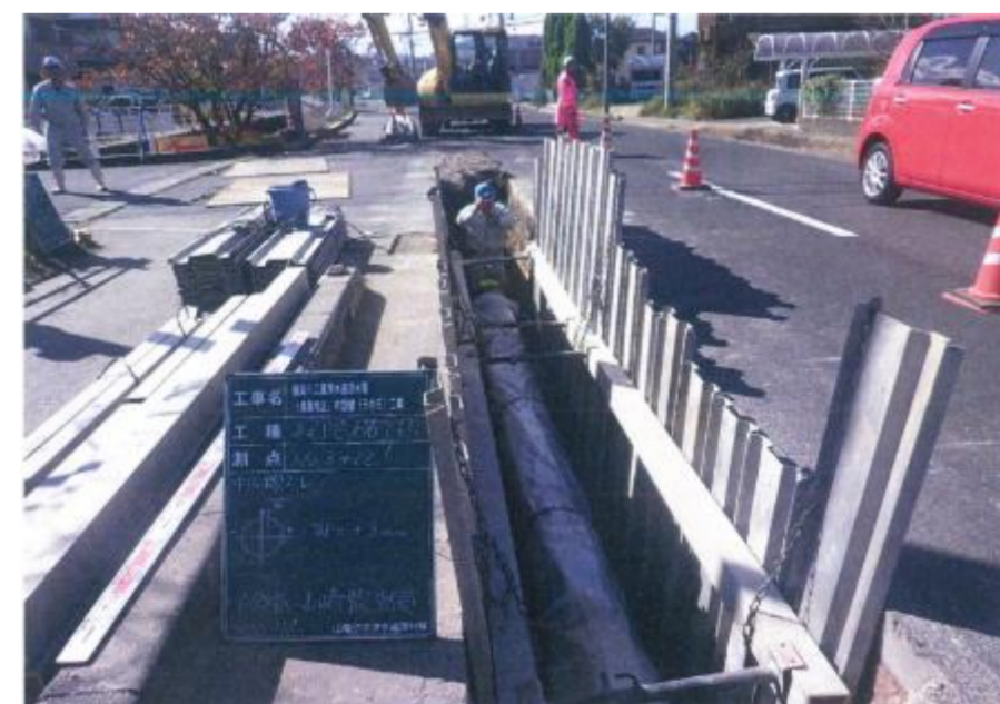
揖屋地区送水管路布設替工事1(飯梨川)
