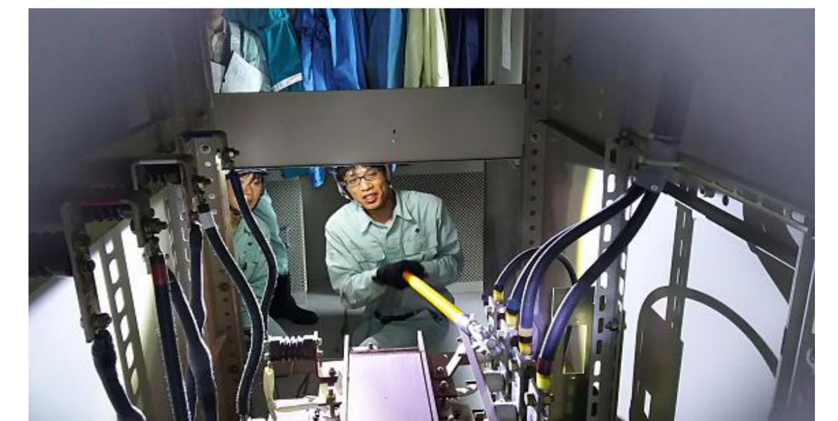
停電作業(江津浄水場)
