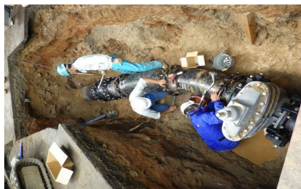
漏水修繕工事(斐伊川水道管路松江市布志名配水池付近)
