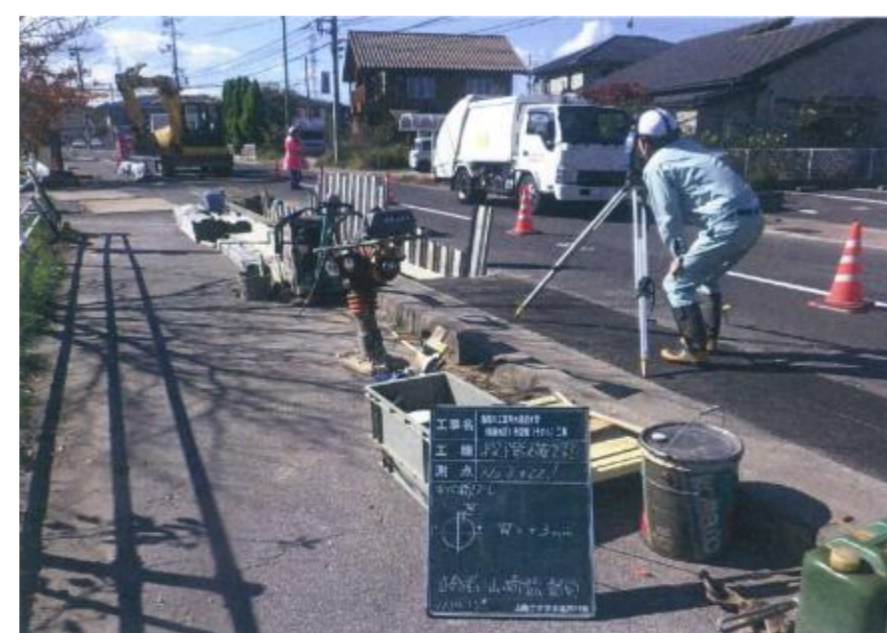
揖屋地区送水管路布設替工事2(飯梨川)
