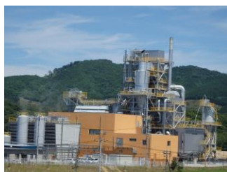
木質バイオマス発電所
