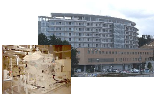
図表 2-9-1. 松江市立病院（天然ガスコージェネレーションシステムの導入）
