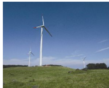
図表 2-2-2. 隠岐大峯山風力発電所
