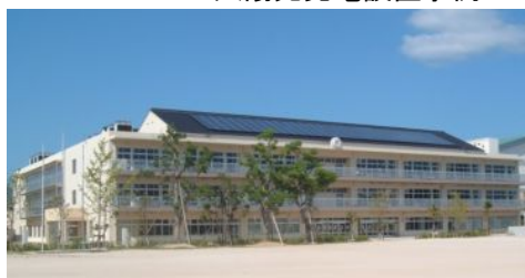
図表 3-4-1. 松江市母衣小学校での太陽光発電設置事例
