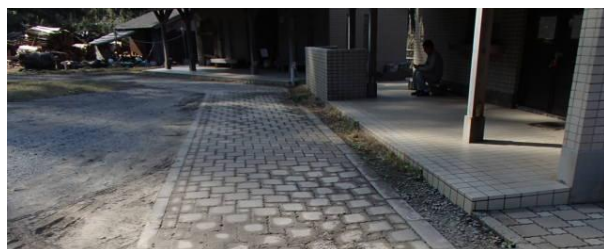
【着工前】管理棟前
