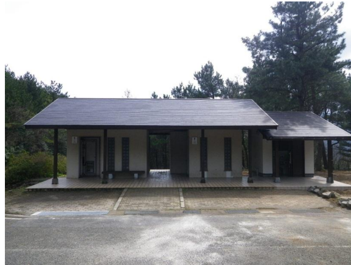
【完成】既存トイレ（左側）および新設多目的トイレ（右側）
