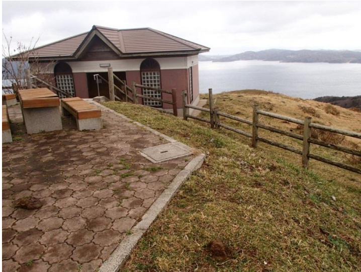
【着工前】既存トイレ
