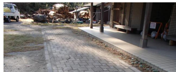
【着工前】トイレ棟前
