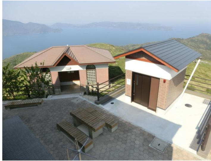
【完成】既存トイレ（左側）および新設多目的トイレ（右側）
