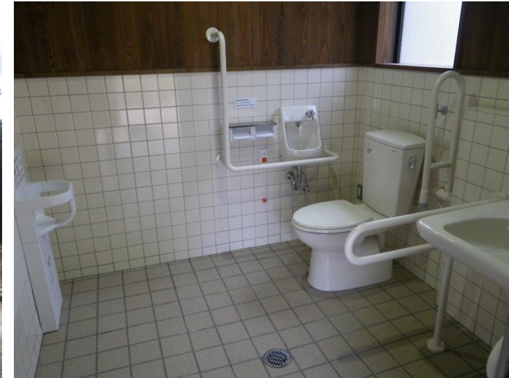
【完成】新設多目的トイレ内観
