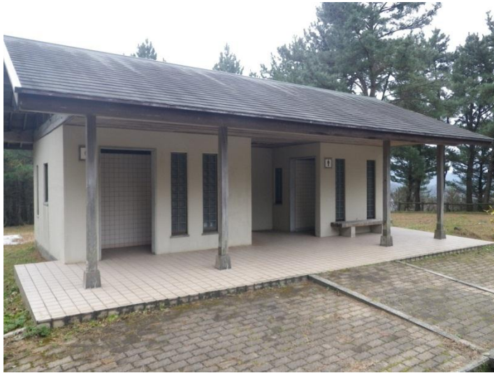
【着工前】既存トイレ
