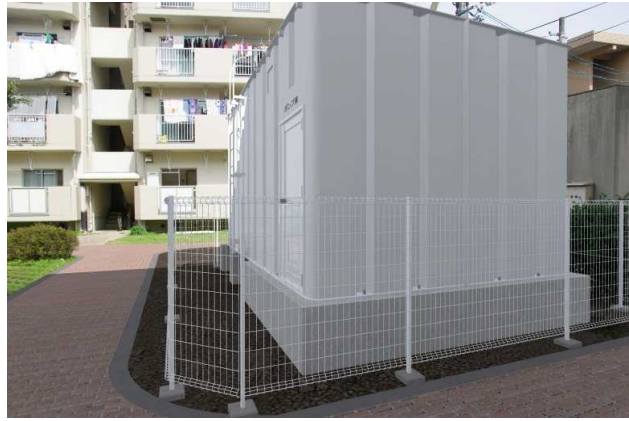
外観（塩冶団地受水槽改修工事）
