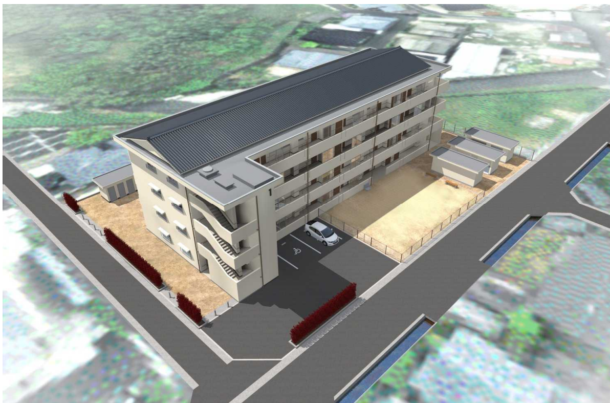
外観（有原団地1号棟外壁改修工事）
