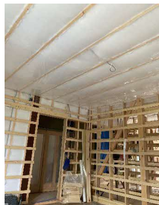
天井の改修風景
