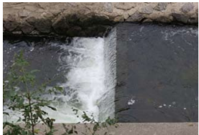
図10. 江の川取水堰の魚道隔壁部に剥離流が生じている
