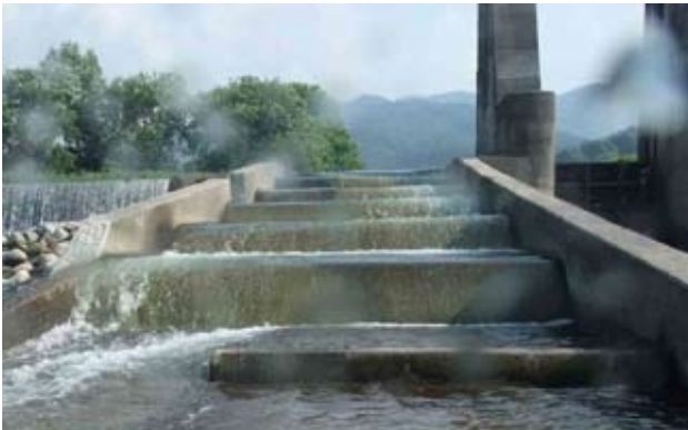
図 12. 隔壁にアールをつけた改良例
