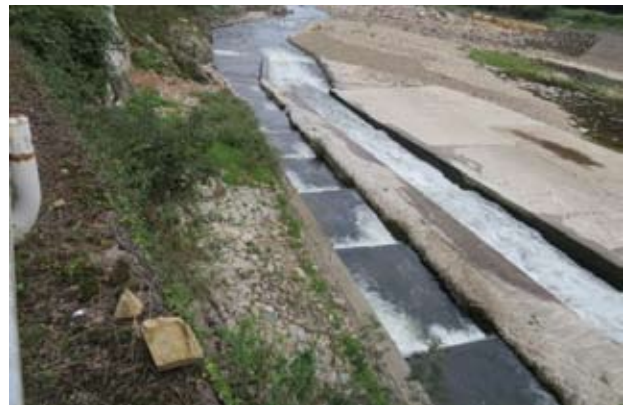
図9. 江の川取水堰の外観(上写真)と左岸側に付設された魚道(下写真)
