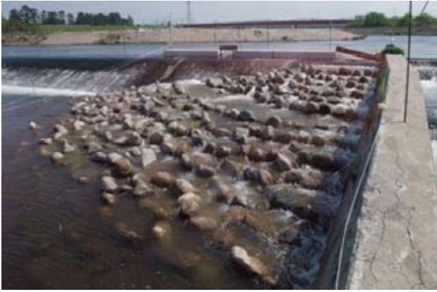
図 11. 小わざ魚道（鳥取県日野川車尾堰堤）
