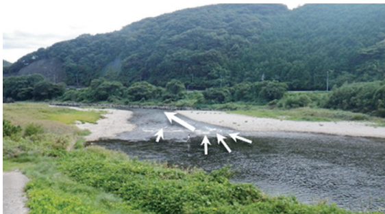
図6. 長田の瀬の概観（矢印は流向を表す） 右岸側で一本瀬となっている
