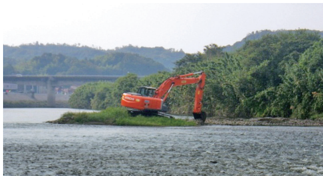
①H23年度に築堤した左岸導流堤の一部開削
