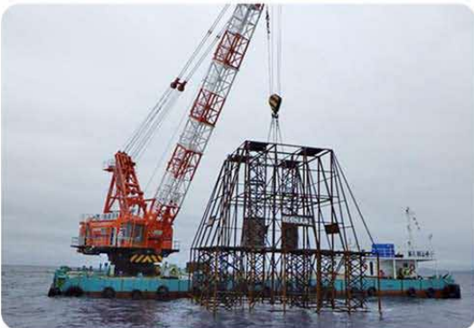
ぎょじょう ちんせつ 魚礁の沈設
