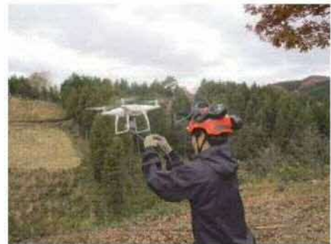
■UAV を活用したリードロープ運搬
