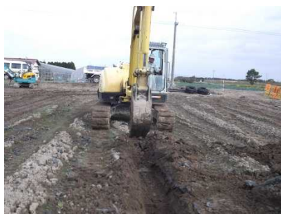
ショベルによる作溝
