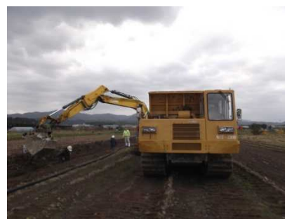
溝内へのバラス敷設
