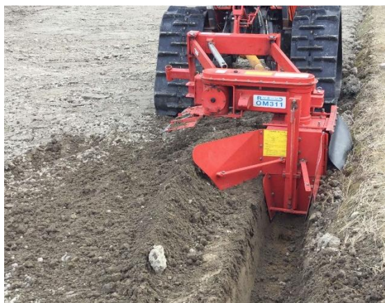
溝堀（明渠）の作業受託
