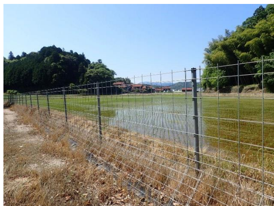
鳥獣侵入防護柵の設置
