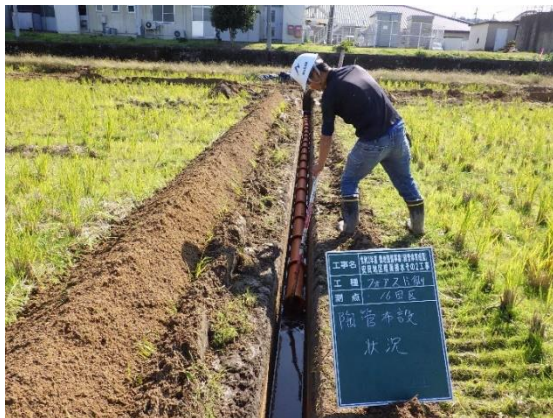
暗渠排水の新設
