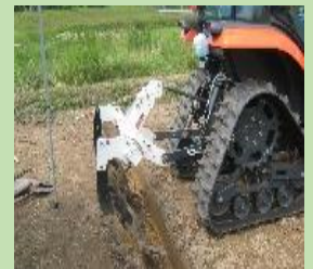
【弾丸暗渠の施工】
