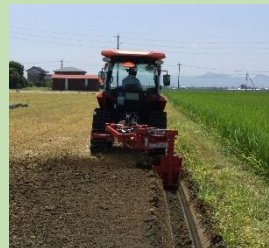
【額縁明渠の施工】
