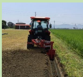
【額縁明渠の施工】
