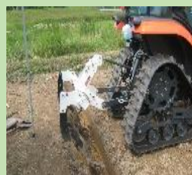
【弾丸暗渠の施工】
