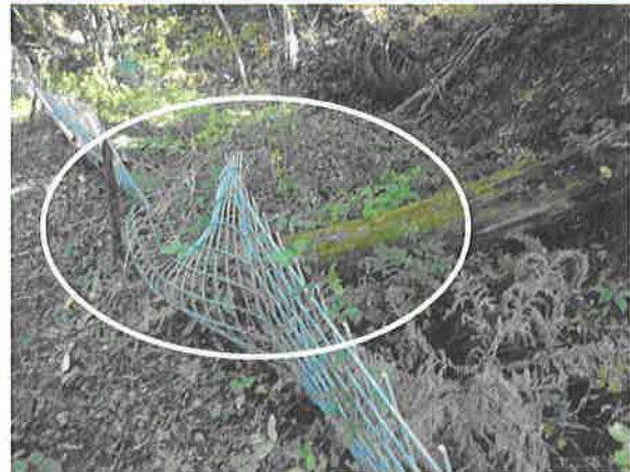
倒木によるフェンスの破損
