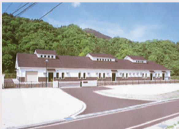
桜江中央地区の污水処理場
